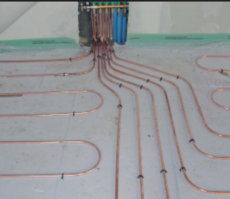
I COLLEGAMENTI. Nel caso dei moduli a pavimento, gli unici tratti che vengono stesi in maniera tradizionale sono i collegamenti ai collettori.
