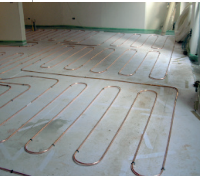
LA POSA. Un pavimento radiante in moduli: le serpentine in rame vengono installate più velocemente; il passo tra i tubi è di 25 cm (15 cm in caso di locali come i bagni).
