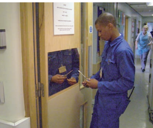
Ospedale Selly Oak di Birmingham. Installazione di piastre in ottone in zone di frequente contatto
